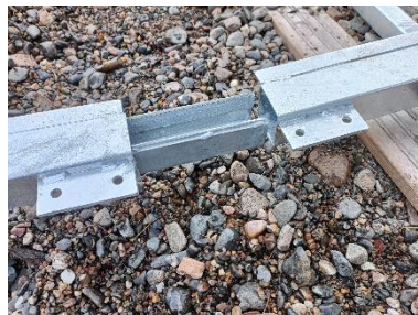
Kiskoelementtien liitoshylsy
